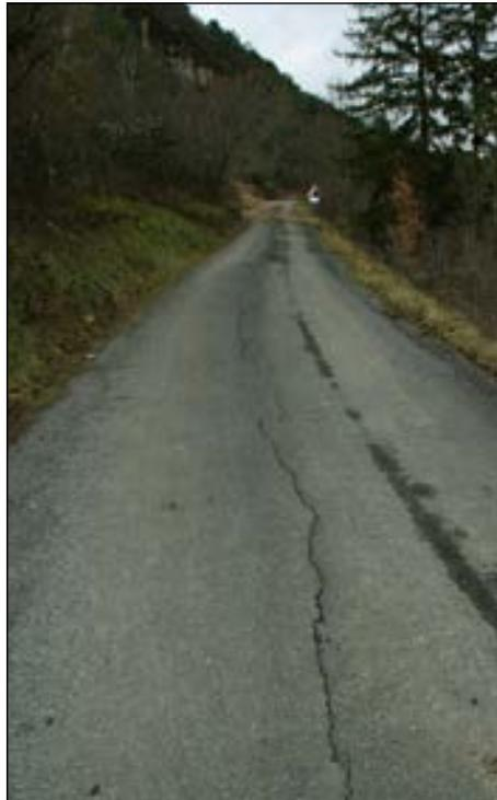
Un affaissement de la route du Causse a imposé l'installation d'un drain, posé par l'entreprise BTPM12. La réfection de la chaussée a été réalisée par l'entreprise Germain.
